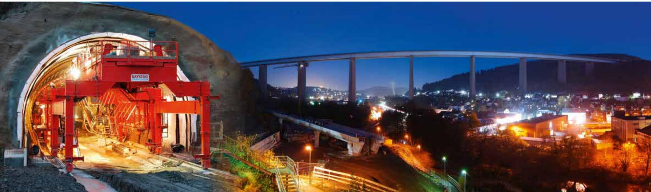
417 m misst der bergmännische Teil des Bühltunnels, der im Zuge des Neubaus der B 62n (Hüttentalstraße) im Süden der Stadt Siegen (Niederschelden) zur Unterquerung des dicht bebauten Bühlrückens errichtet wurde. Nach Verfüllung der alten Bergbaustollen im Jahr 2010 begann das Auffahren des Tunnels im Oktober 2011. Der Tunneldurchschlag erfolgte im Dezember 2012; Foto: StraßenNRW/Züblin.
